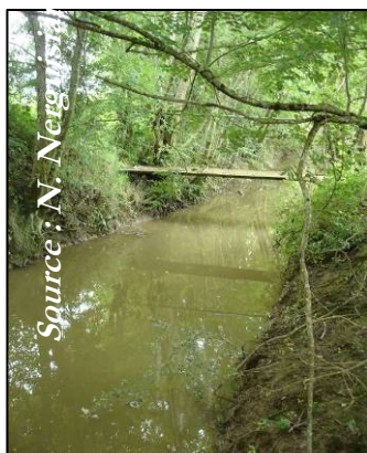
Photographie 12 : Fossés à fonction d'évacuation
